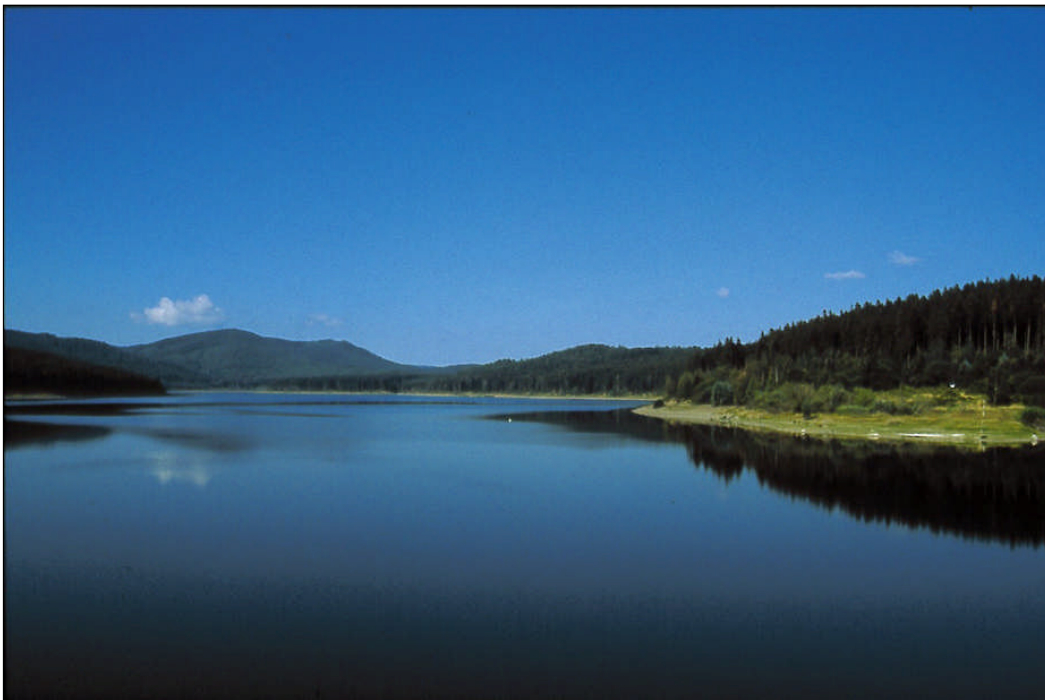
Die Granetalsperre in der Nähe von Goslar dient der Wassergewinnung.
